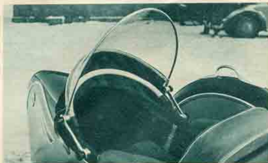
Rechts: Die Frontscheibe ist beim Stoye doppelt verstellbar und vollständig umlegbar.
